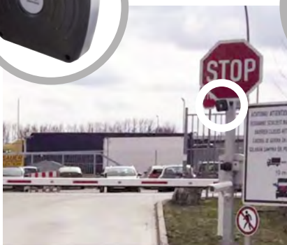
Die Weitbereichsleser wurden an Verkehrsschildern angebracht.
